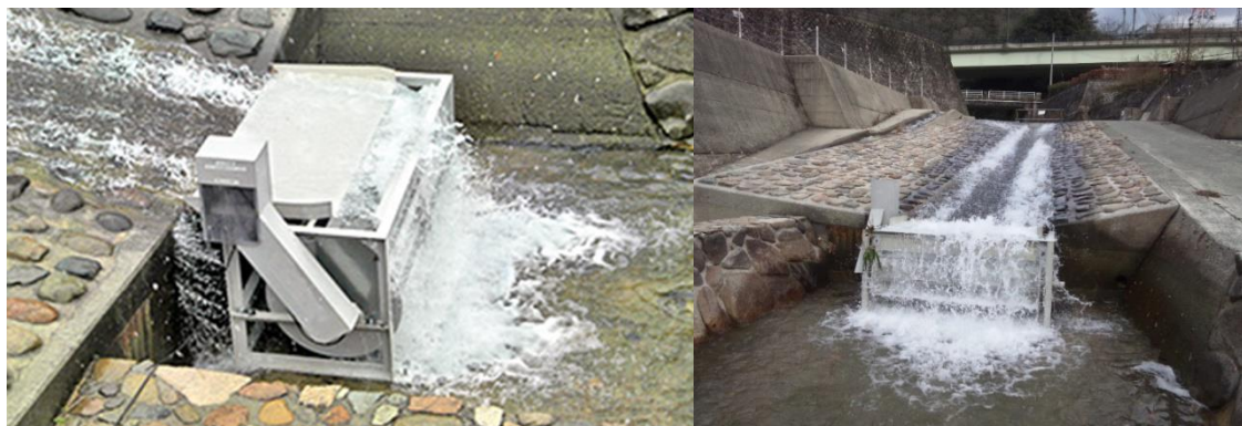
図 5-3 小規模河川に設置されたマイクロ水力発電機の例
