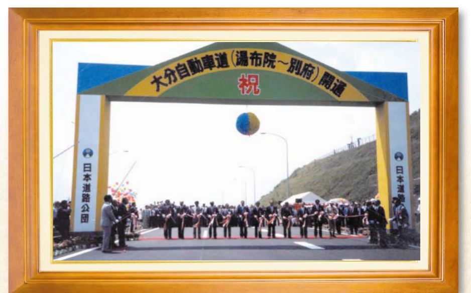
▲平成元(1989)年 大分自動車道(別府～湯布院間)開通 約7年の歳月をかけて完成した道路。別府から湯布院まで約20分で移動が可能となった。7月20日には、別府湾サービスエリアで開通祝賀式が行われ、野田建設大臣、宮繁日本道路公団総裁、平松知事らが出席した。
