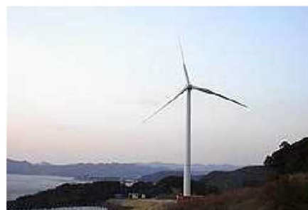
風力発電施設の設置例
