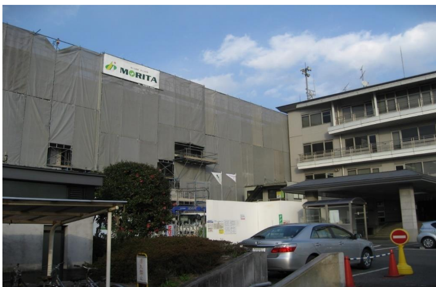
耐震化工事を行う、役場旧庁舎
