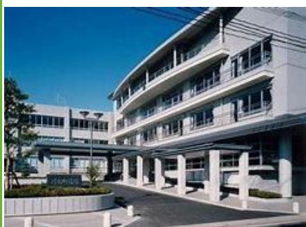
日出町役場（本庁舎新館）
