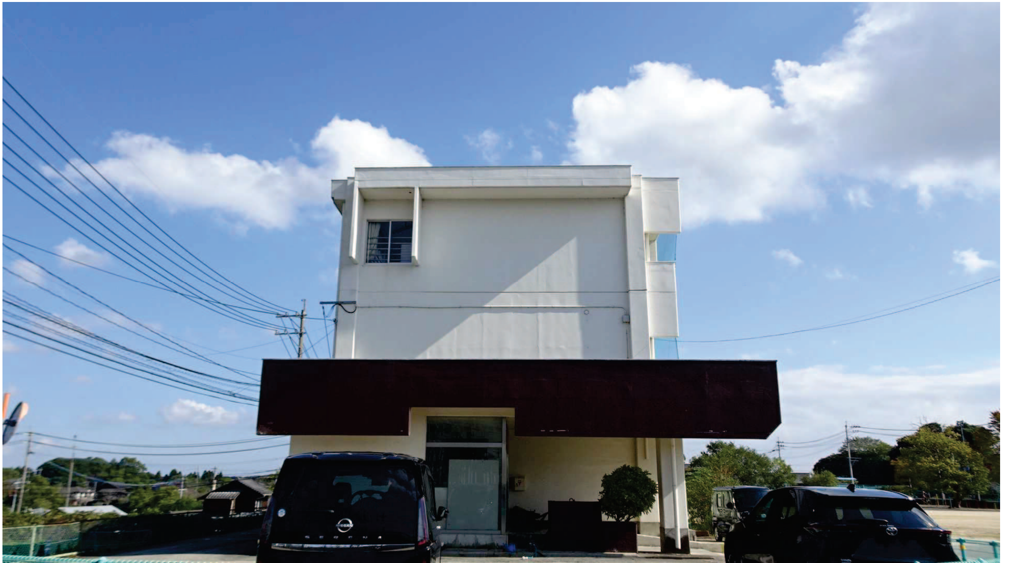
【日出町立川崎小学校 管理教室棟 西面外観】
