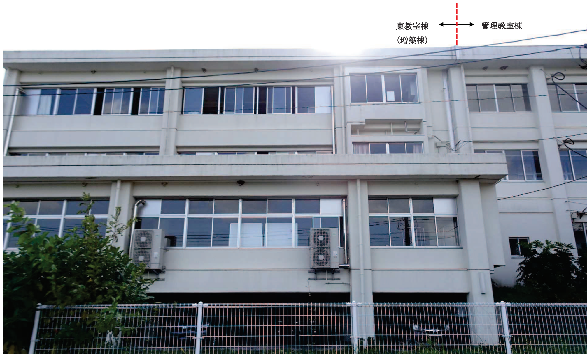
【日出町立川崎小学校 東教室棟（増築棟） 北面外観】
