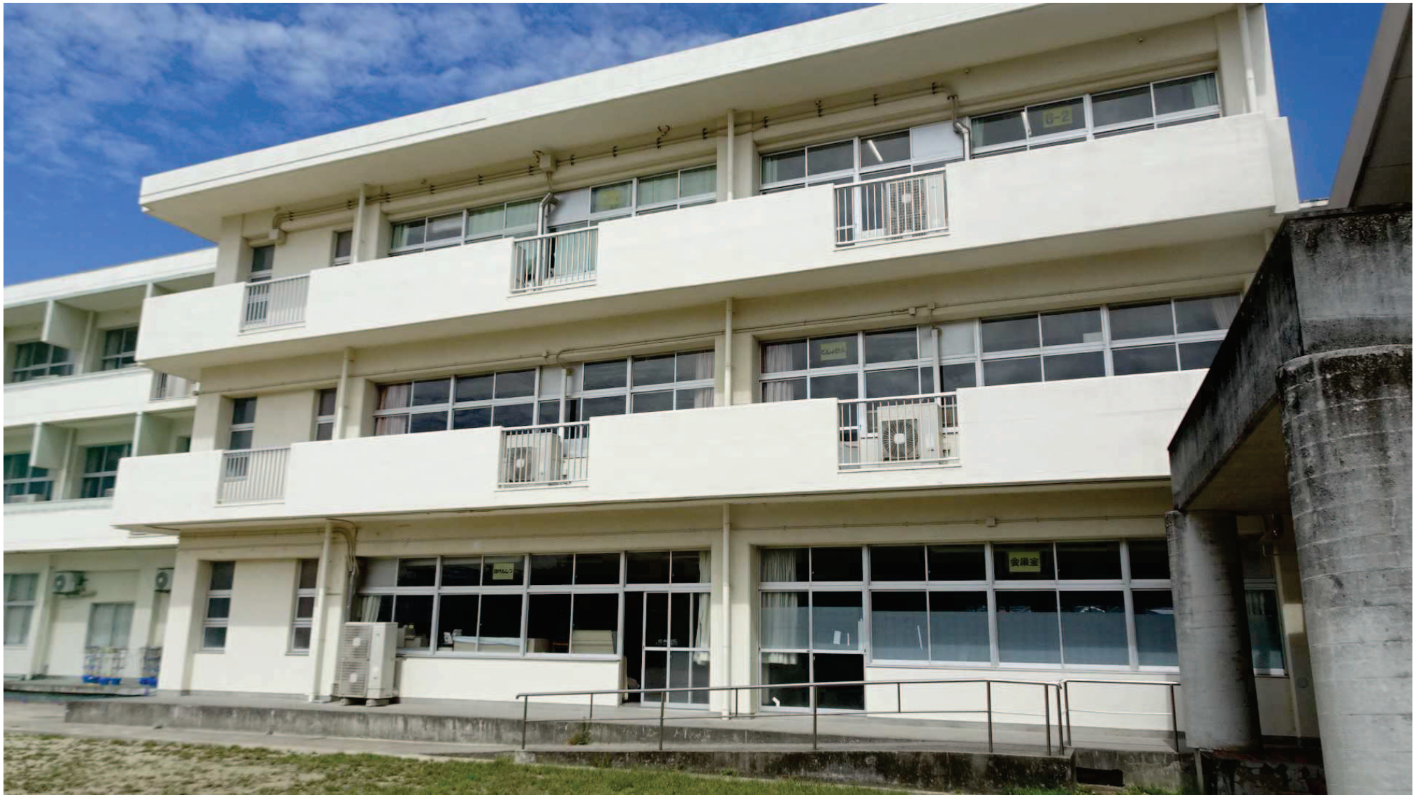
【日出町立川崎小学校 東教室棟（増築棟） 南面外観】
