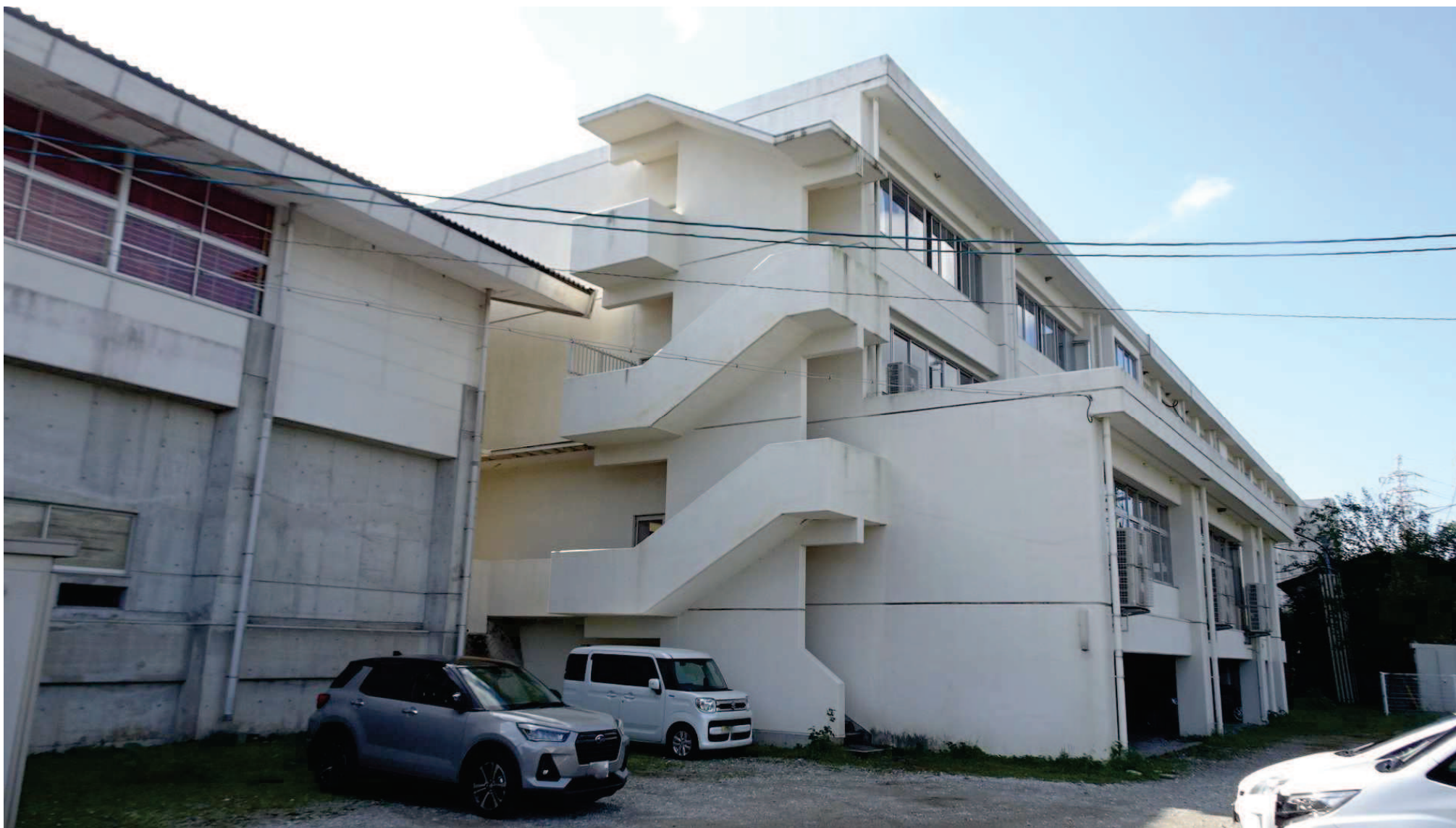
【日出町立川崎小学校 東教室棟（増築棟） 北東面外観】
