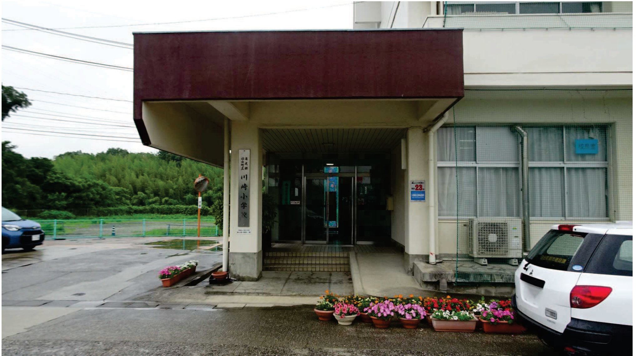
【日出町立川崎小学校 既存職員玄関（改修後は印刷室となる）】
