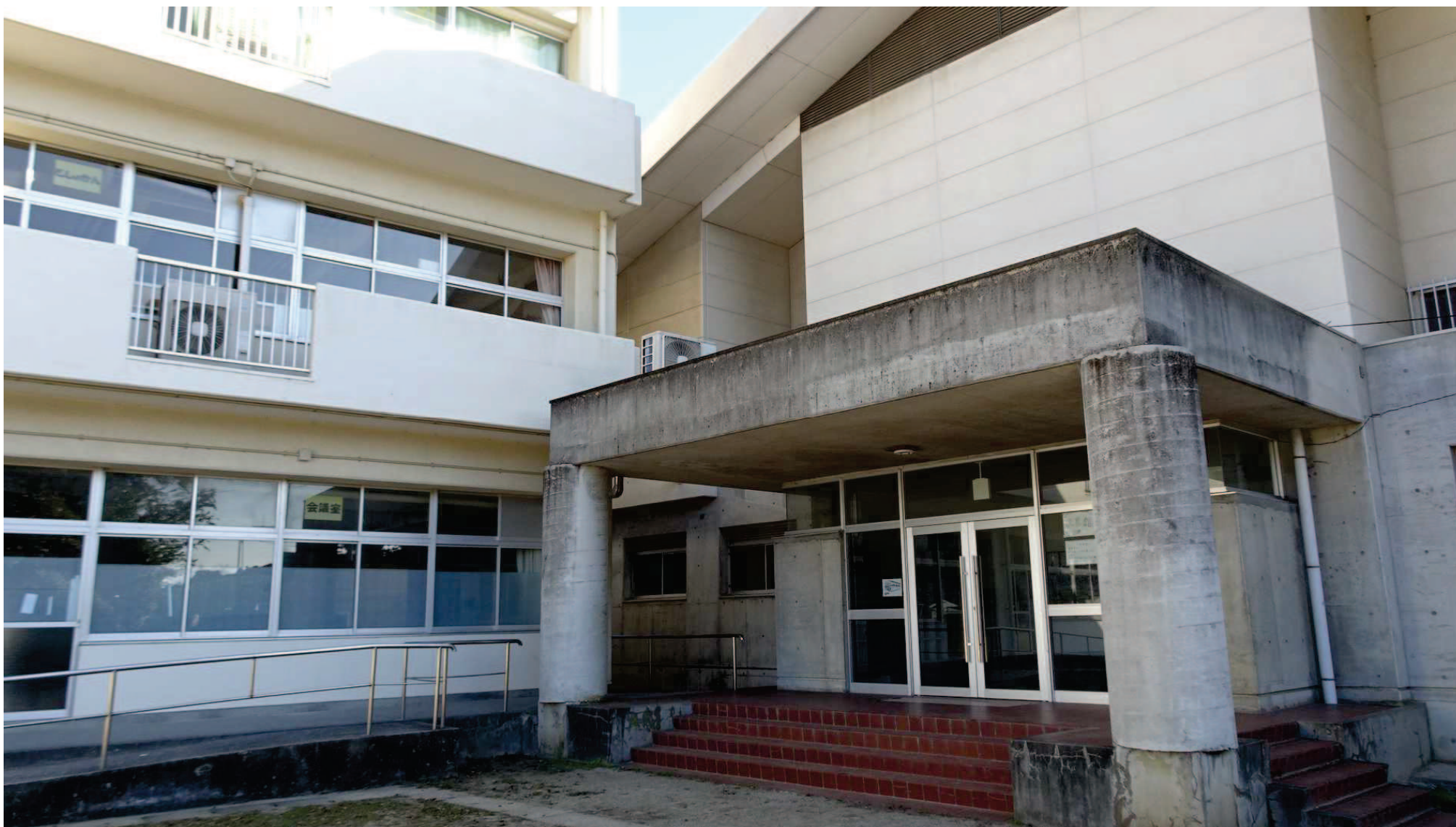
【日出町立川崎小学校 東教室棟（増築棟）・屋内運動場間の接続部 南面外観】
