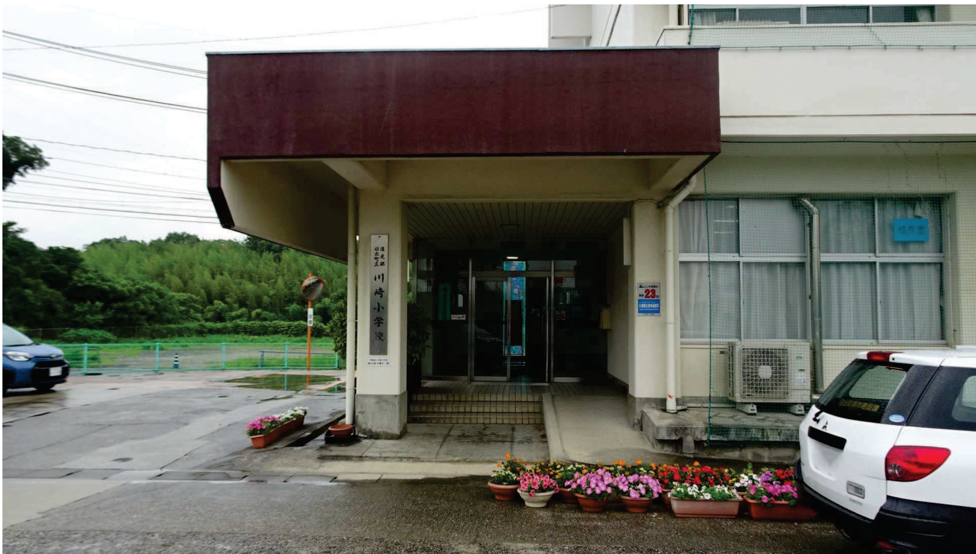
【日出町立川崎小学校 既存職員玄関（改修後は印刷室となる）】
