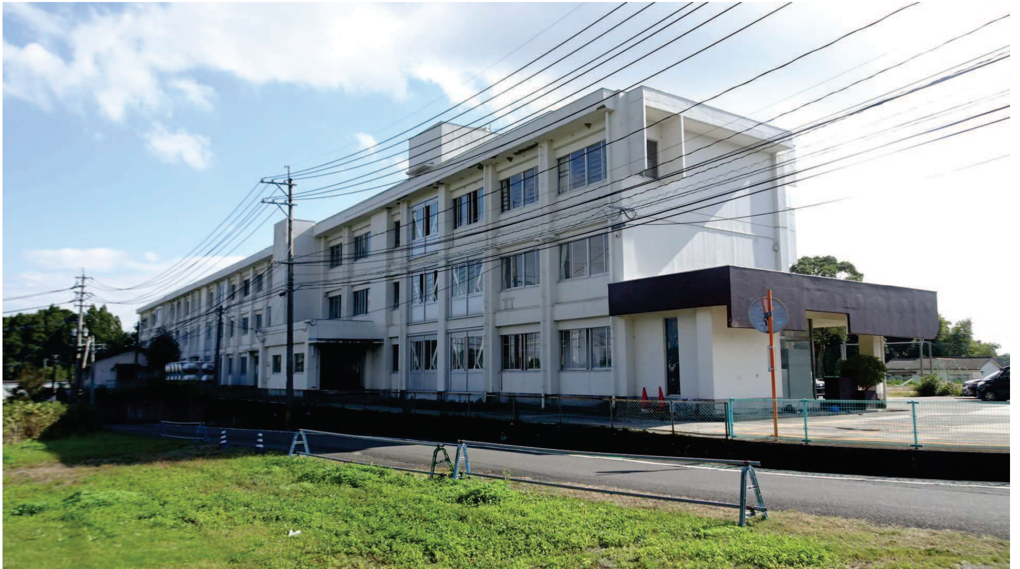
【日出町立川崎小学校 管理教室棟 北面外観】
