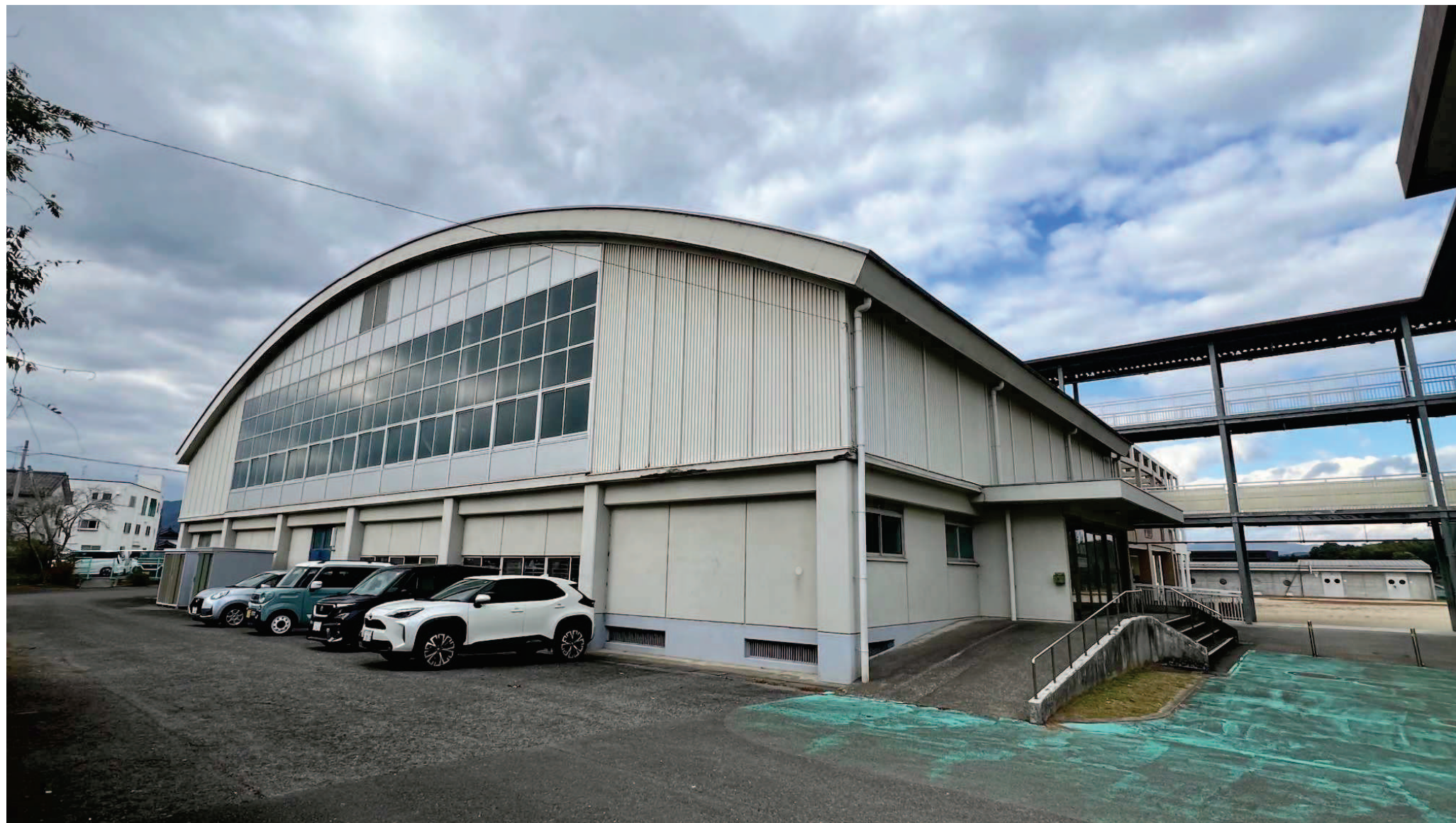
【大神小学校 屋内運動場 外観】
