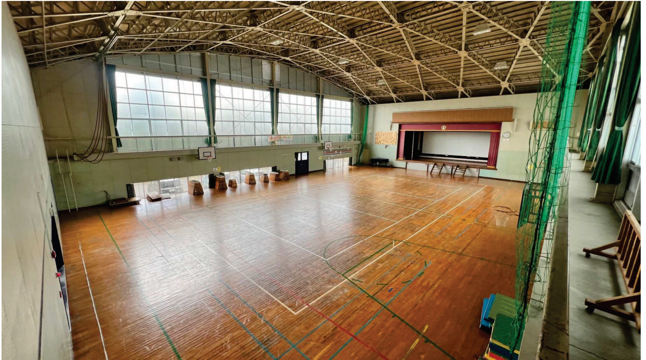
【大神小学校 屋内運動場 内観（玄関側キャットウォークより撮影）】
