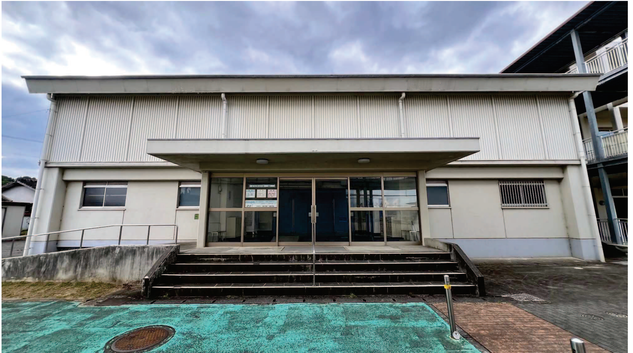
【大神小学校 屋内運動場 外観】
