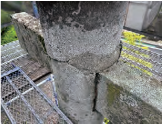
写真 10-9 毀損柱の修理痕
