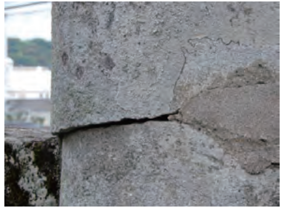
写真 10-10 柱の割損及びズレ
