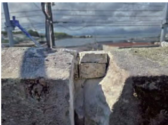
写真 10-5 鉛塊による契継ぎ
