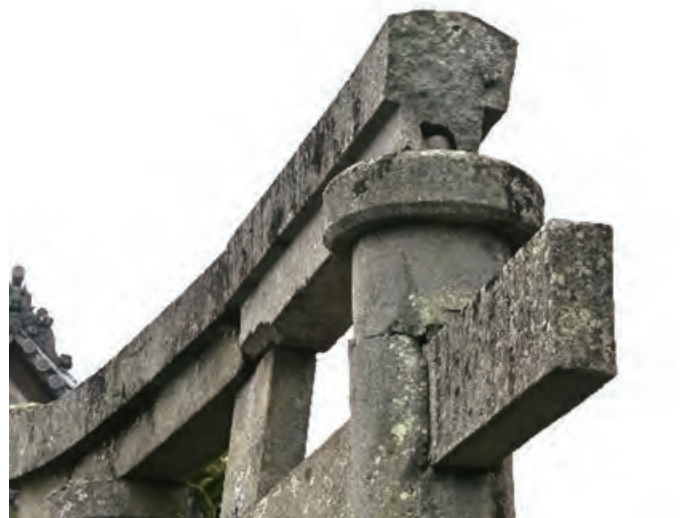
写真9 き損状況詳細（折損、破断、不陸）
