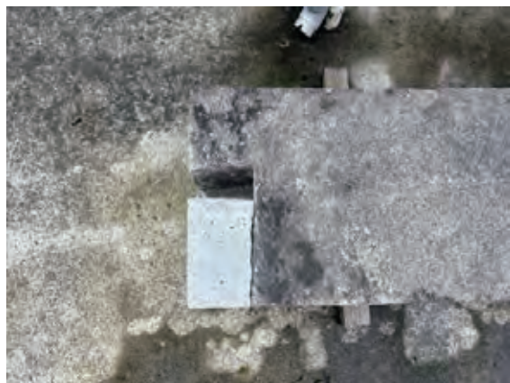
写真 10-33 新材取り付け後
