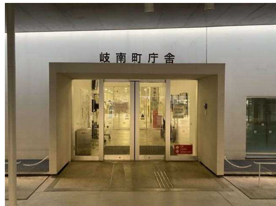
岐南町庁舎 入口
