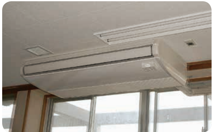
エアコンの設置が進む町内の小学校
