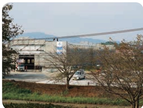
工事が進む川崎工業団地
