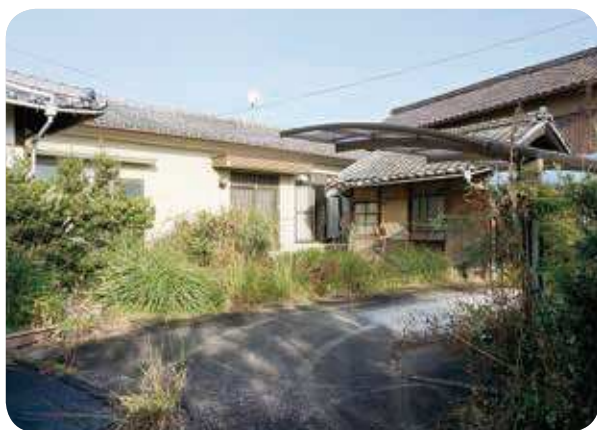
整備改修前のお試し居住施設
