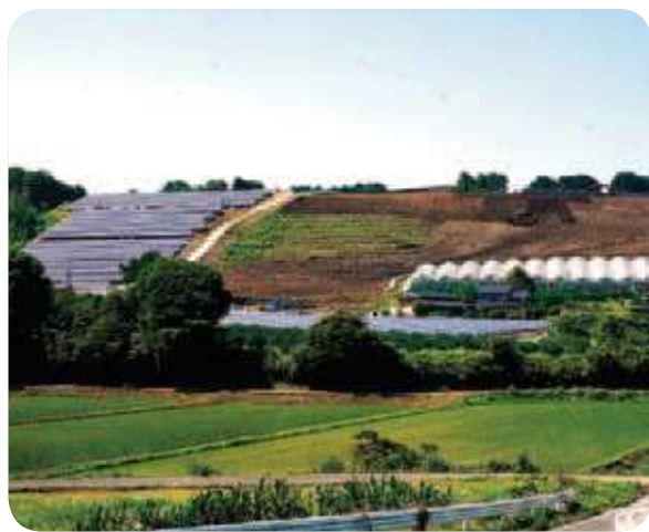
太陽光発電設置の工事現場
