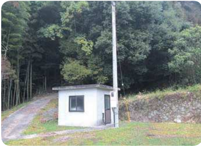
おいしい水を大切に（地域水道組合のポンプ施設）
