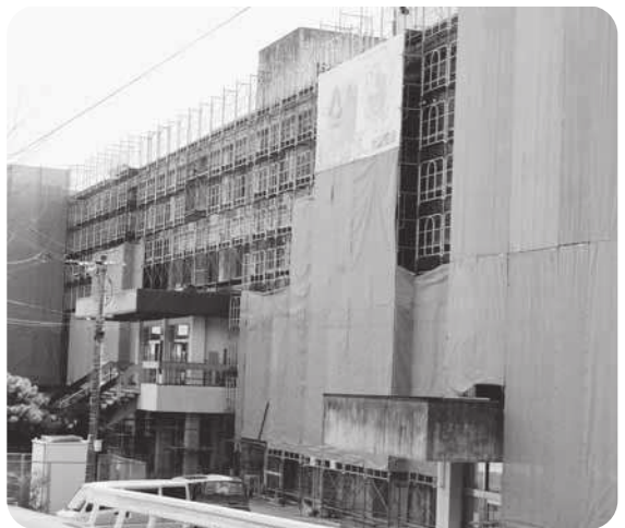
制震工事と壁面調査中の日出中学校
