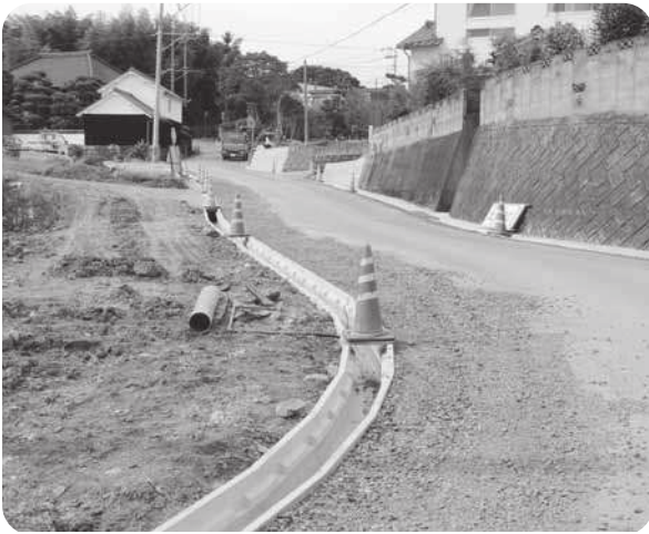
地元の要望で道路を改良（町道辻ノ尾千騎線）
