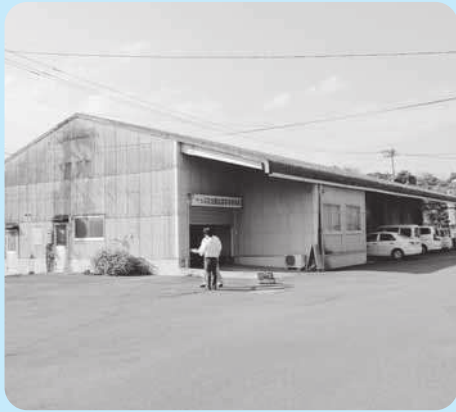
JA倉庫を加工施設に（川崎）
