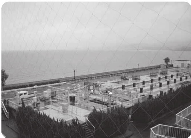
3系列目を増設工事中の浄化センター
