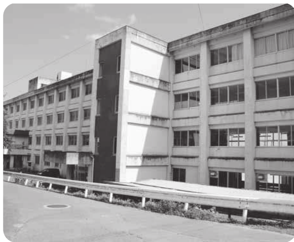
今年度耐震工事に着手する日出中学校
