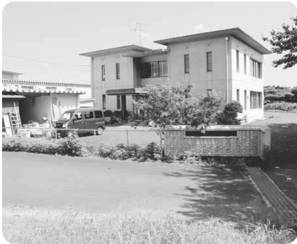
有効な活用を（県土地改良事業団体連合会事務所跡）
