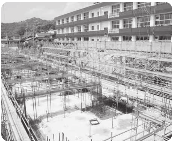
豊岡小学校校舎新築工事状況
