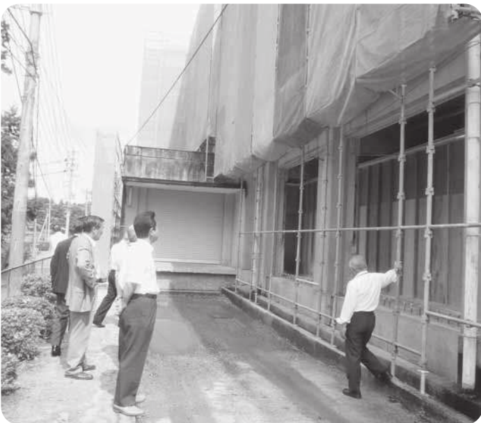
川崎小学校の耐震補強工事
