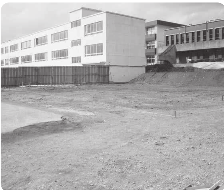
工事を着手しました（豊岡小学校改築工事）
