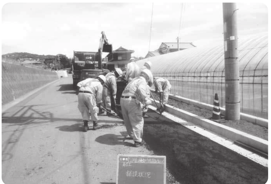
生活道路の改良を行います（町道の改良工事）
