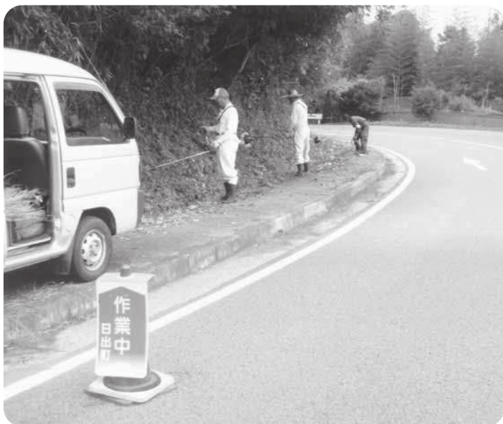
維持管理を行っています（町道の草刈り）
