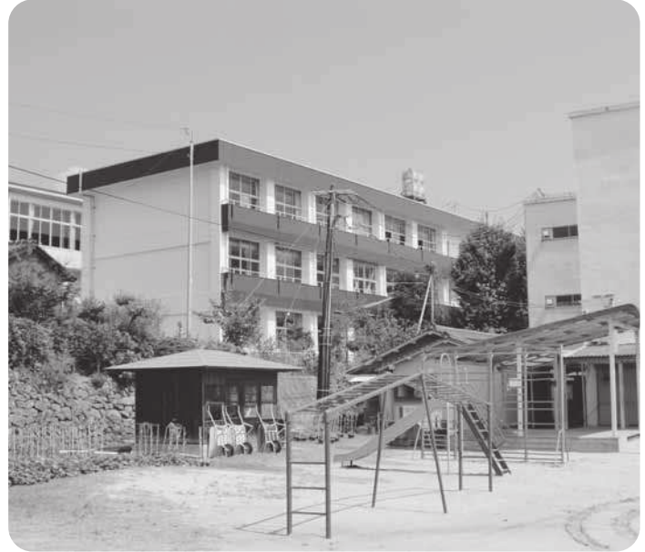
これで安心（豊岡小学校特別教室棟耐震工事完了）
