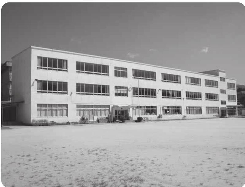
待望の建替え工事が始まります（豊岡小学校）
