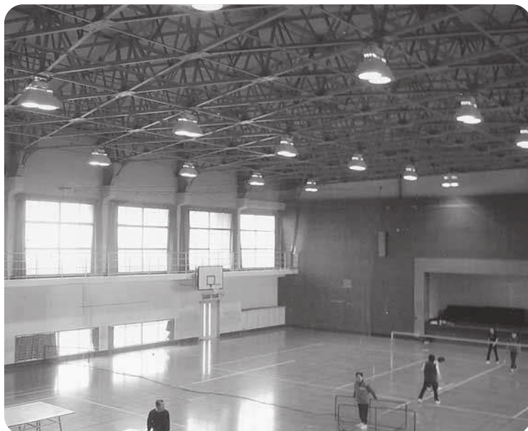
社会体育に支障のない照明を（屋内競技場）
