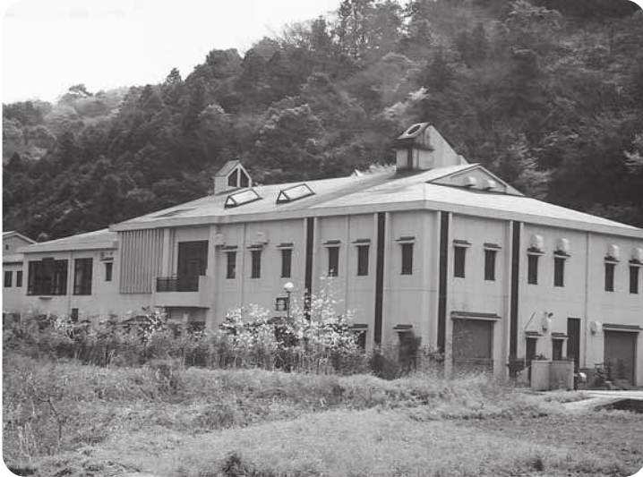
低コスト処理で、環境保全に取り組む (杵築速見環境浄化センター)
