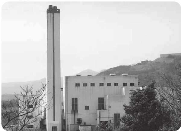
飽和状態のためゴミの減量化が急務 (藤ヶ谷清掃センター)
