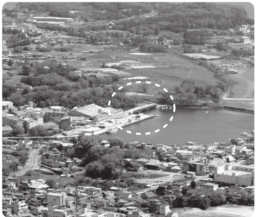
臨港大橋が人口増の起爆剤になるか（日出港から内野）
