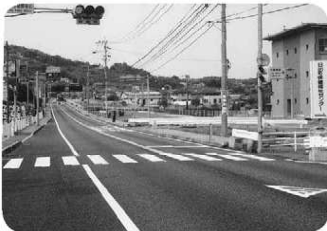
再開の目途がたない国道10号線拡幅工事
