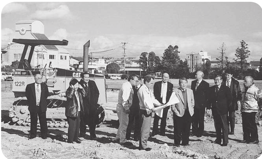
町づくりの大きなカギ（工事進捗状況を視察）
