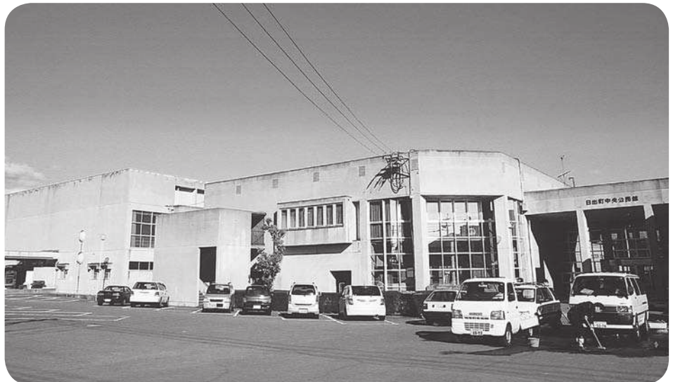
傷みがひどくなった公共施設(日出町中央公民館)
