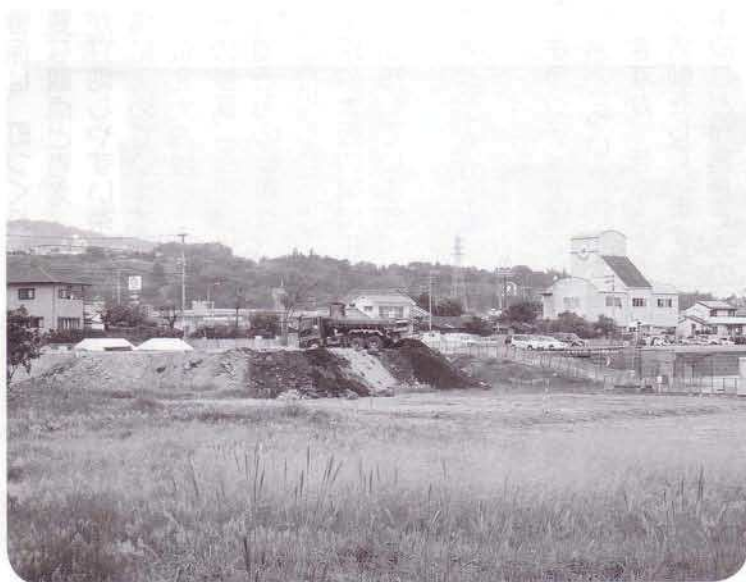
埋め土作業が進む高校跡地
