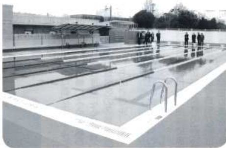
「早く泳いでみたい」完成した大神小プール
