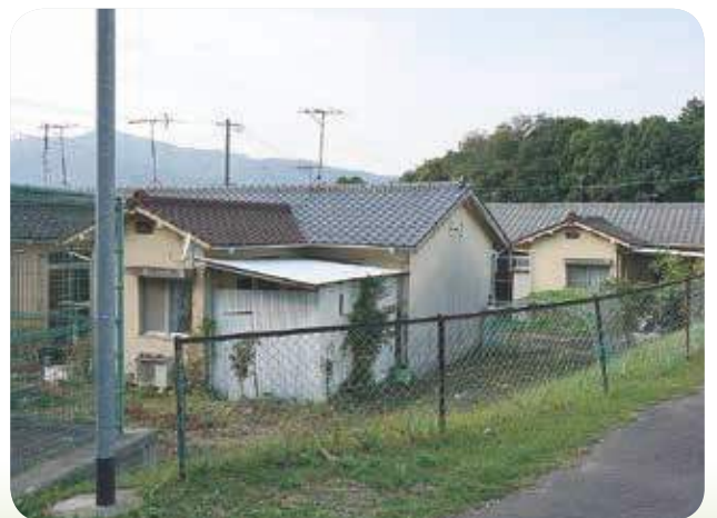
老朽化が進む町営住宅
