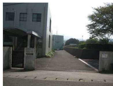
日出町浄化センター
