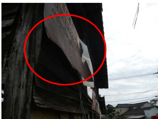
鉄製看板落下の危険性
