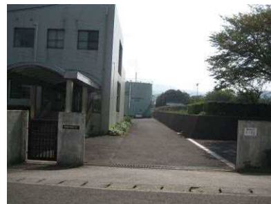
日出町浄化センター
