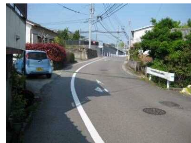
豊岡小学校周辺道路
