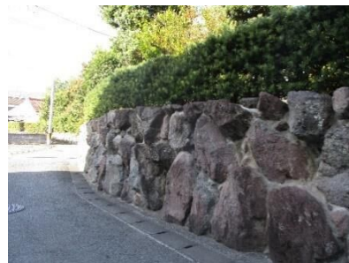
石等の自然的な素材を使用した例
