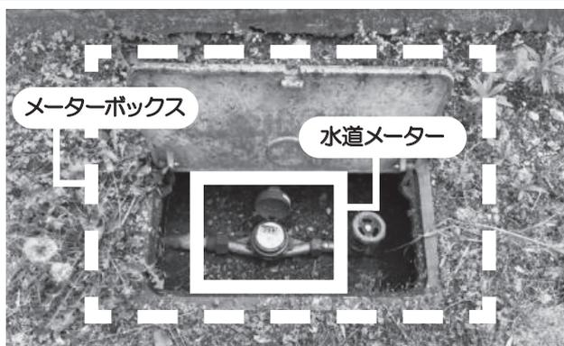
メーターボックスは水道使用者の所有物です。メーターボックスや蓋が破損した状態で使用すると水道メーターや止水栓などが壊れる原因にもなります。
