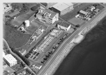
日出町浄化センター
