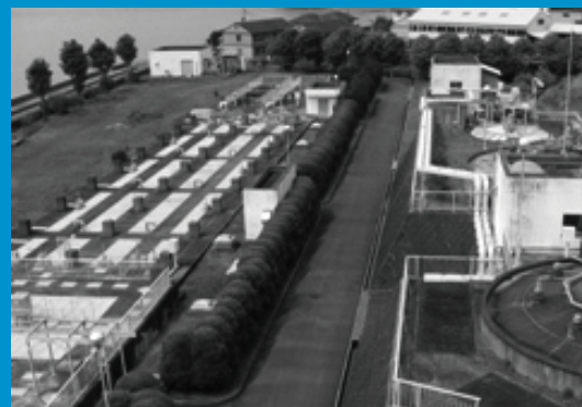
日出町浄化センター
