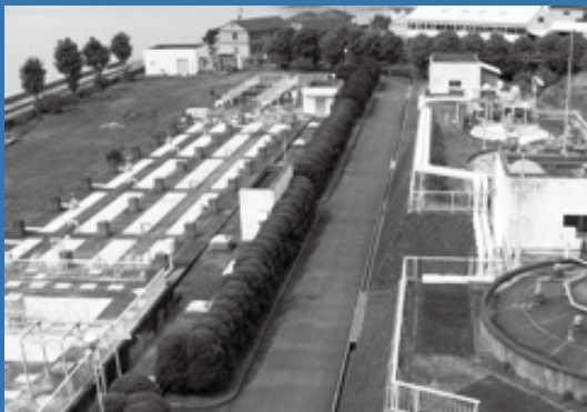
日出町浄化センター
