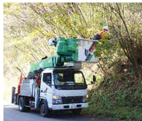
高所作業車を用いての伐採作業
