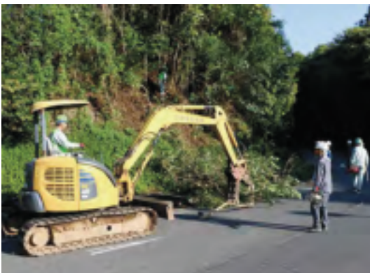
伐採作業の様子
