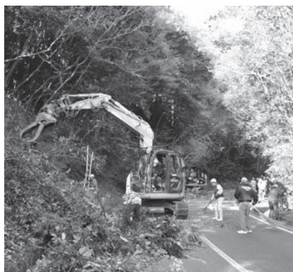
支障樹木の伐採作業を行う参加者
