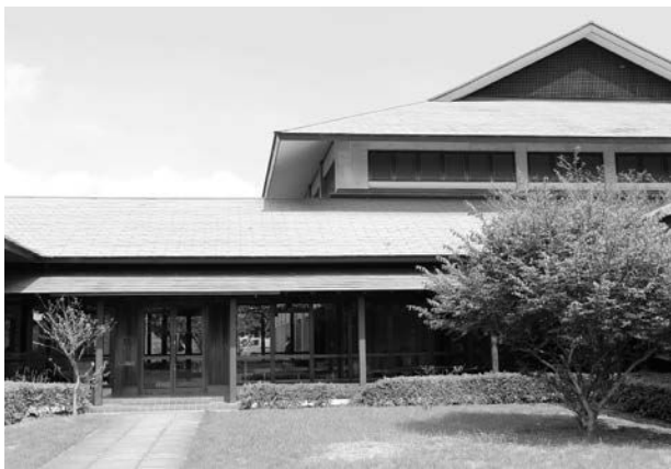
トレーニングジムや会議室も備えた日出町川崎体育館
