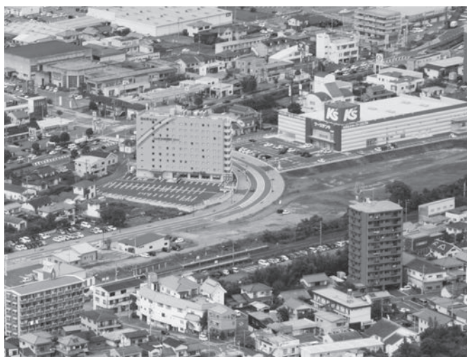
国道10号から暘谷駅北側をつなぐ、町道暘谷駅北口線
