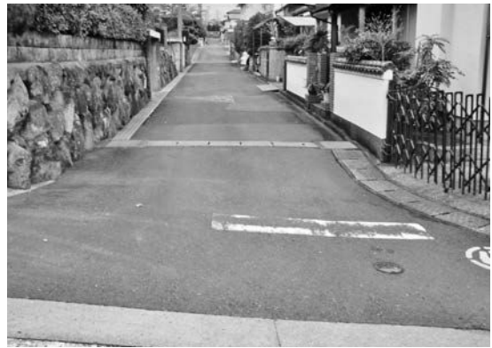
町道豊岡住宅団地線
