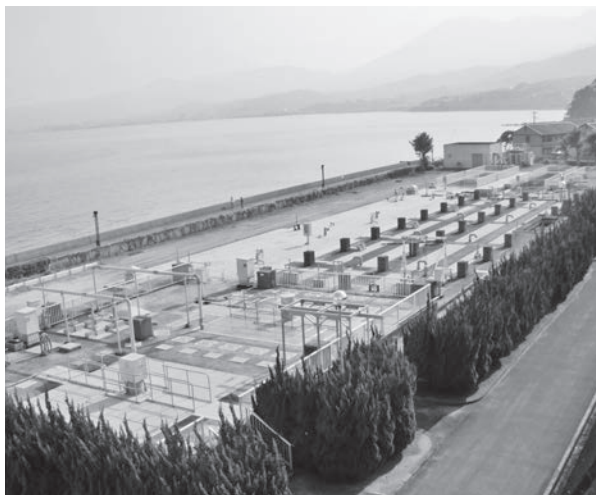
日出町浄化センター
