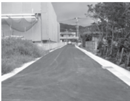
町道堀高校線舗装工事
