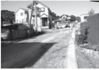
鳴川今井線の拡幅工事
