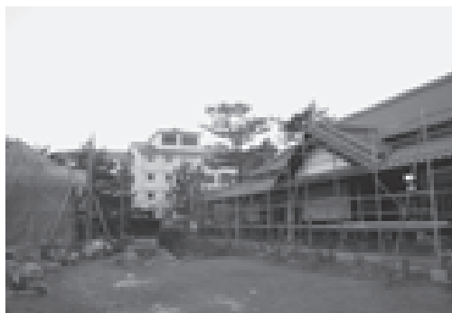
建設中の陽谷城二の丸館と裏門櫓
