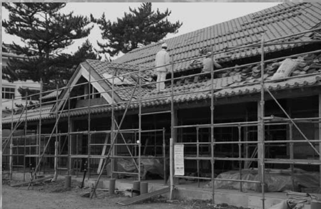
建設中の暘谷城二の丸館
