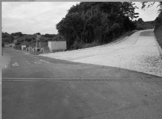
拡幅工事をした町道大神瀬ノ上線
