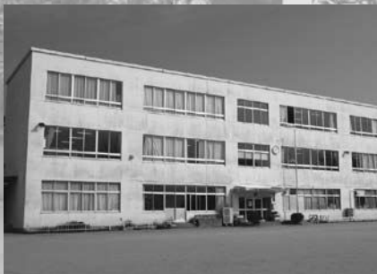
建て替えに着手した豊岡小学校
