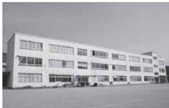
建て替えのための設計委託をする豊岡小学校
