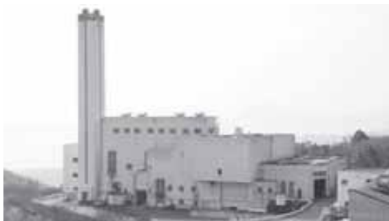
今年度から建て替えに着手する藤ヶ谷清掃センター
