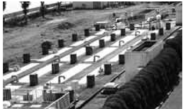
微生物により水を浄化するエアレーションタンク
