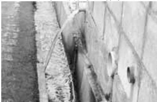
きれいになった側溝
