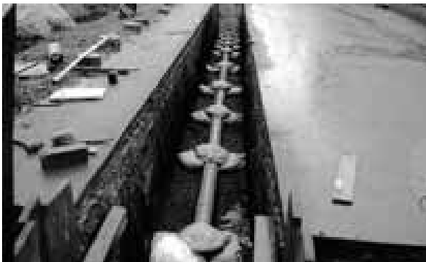
下水道管整備延長の様子
